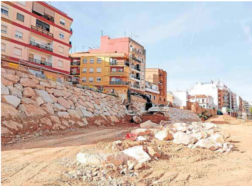
Una excavadora trabaja en la colocación de escollera ayer en Paiporta. LP
